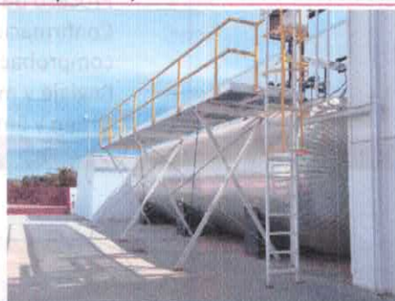
Exterior de la sala de calderas
