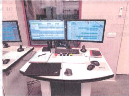
Puesto de control zona torre de llenado
