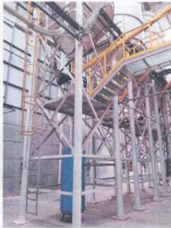
Zona anexa torre de llenado
