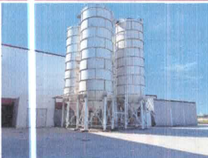
Zona silos exteriores de materia prima
